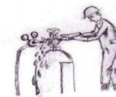
รูป แสดงการตรวจสอบรอยรั่วที่ชุดควบคุมแรงดันและข้อต่อก่อนเริ่มปฏิบัติงาน
